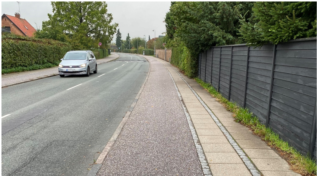
Foto 13: Eksempel med en delt sti bestående af et smalt fortov og en smal cykelsti på samlet 2,5 m uden at der er opspring imellem fortovs- og cykeldelen.
