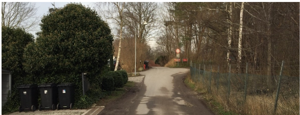
Foto 7: Potentiel vejlukning 3 mellem Tvendagervej 9 og 11.
