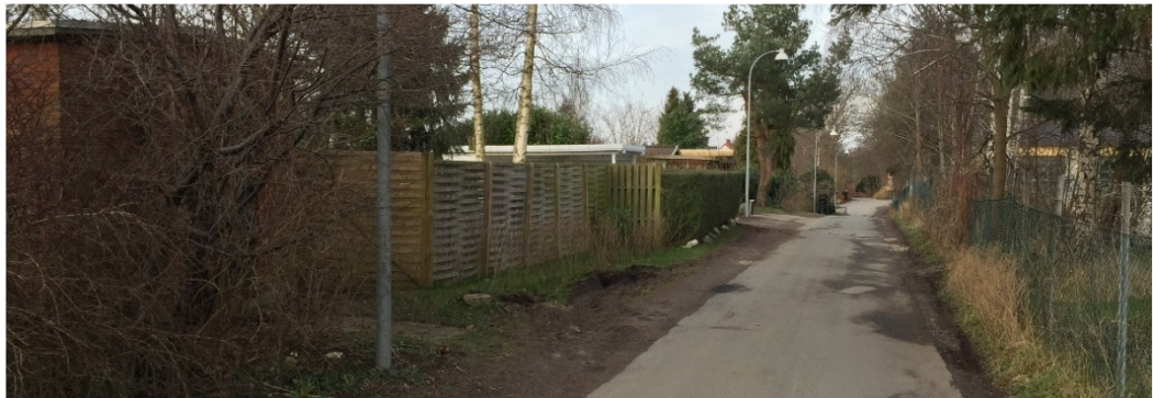
Foto 6: Potentiel vejlukning 2 ved transformestation mellem Tvendagervej 1A og 3.
