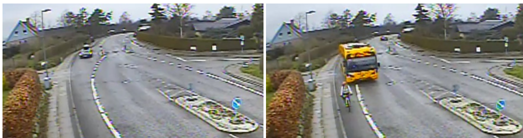
Foto 3: Trafikken på Måløvgårdsvej kører i nogle situationer udenom bumpet. Bussernes forsætninger som følge af vejens forløb med udformning af busbane og midterhelle gør det utrygt for cyklister.
