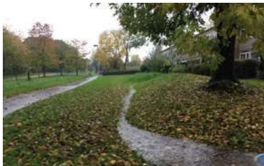
Skybrudsvej, hvor regnvand løber på sti
