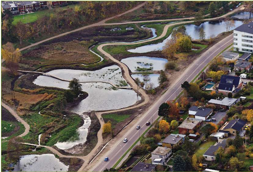
Sillebro Ådal-projektet er et eksempel på et klimatilpasningsprojekt i Frederikssund Kommune. Foto: Frederikssund Forsyning
